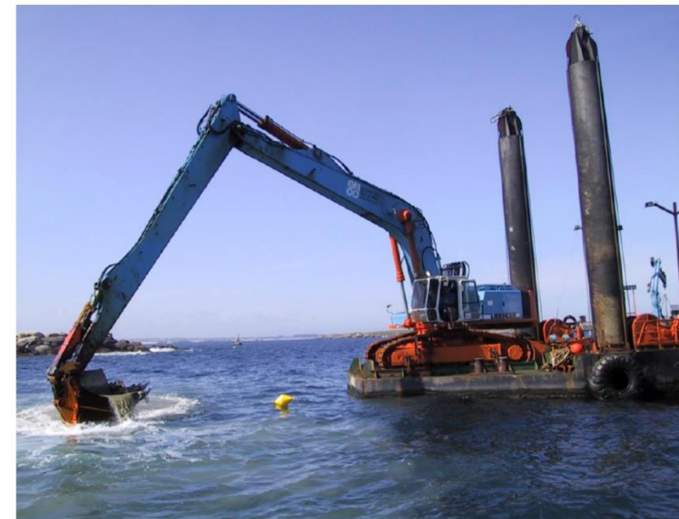
Figure 26 : Pelle mécanique sur ponton flottant
