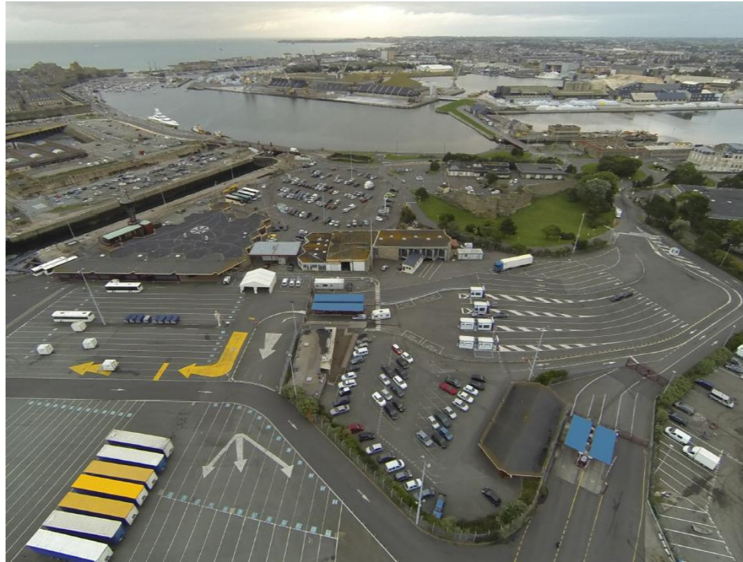
Figure 73 : Photos aériennes et présentation des différentes atmosphères présentes aux abords du terminal (Région Bretagne et SAFEGE).
